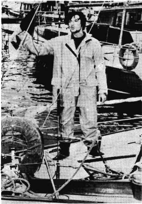
Fig. 2 - Fogar all'arrivo ad Auckland. L'aspetto stralunato e affaticato dice tutto dei duri momenti trascorsi, specie dopo il passaggio dell'Horn. Davanti a lui ben visibile, fissata con un molrone in coperta, è l'antenna di tipo «caricato» ad asta verticale (circa 2,5 m di altezza in tutto) che gli ha permesso ottimi contatti radio durante il viaggio con «om» di tutto il mondo.
